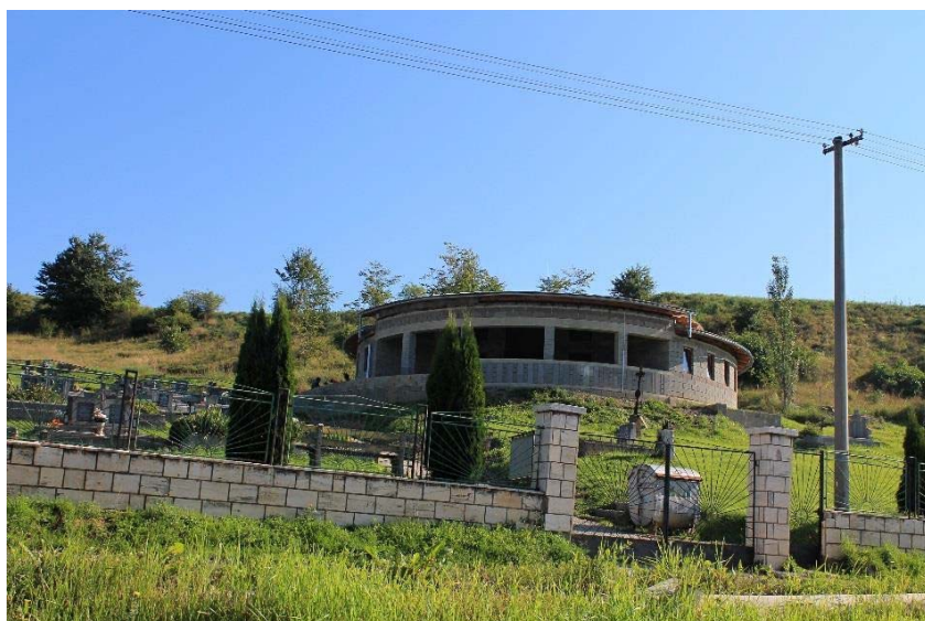
T.F. - Rozostavaný Dom smútku Jánovce
