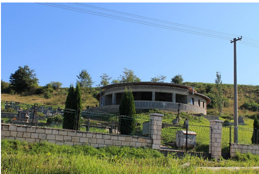
T.F. - Rozostavaný Dom smútku Jánovce
